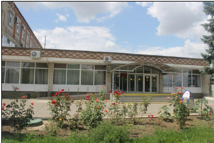
Центральный вход в учреждение
