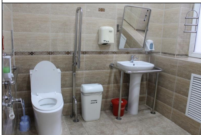
Санитарные узлы оборудованы для инвалидов-колясочников
