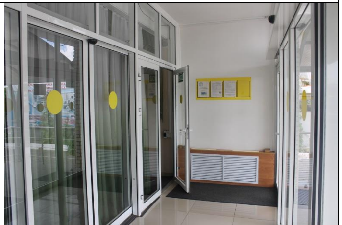
Тамбур, автоматические двери
